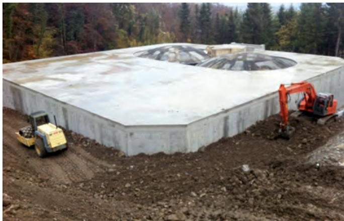
Le chantier au Noiret était de taille. 1675 mètres cubes de béton, renforcés par 260 tonnes d'acier, ont été coulés. Ici dessus on voit les deux anciennes cuves (rondes) entourées de la bâtisse qui abrite les deux nouvelles.
