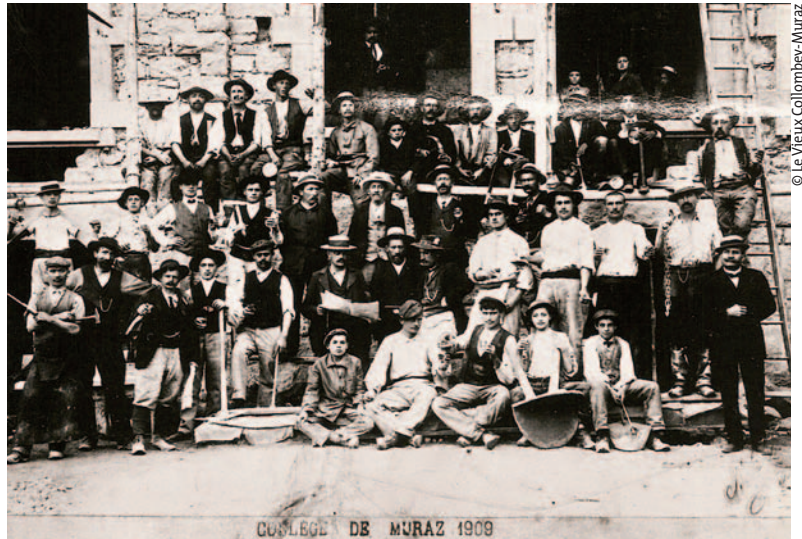
Construction de l'école en 1909, fin du gros œuvre
