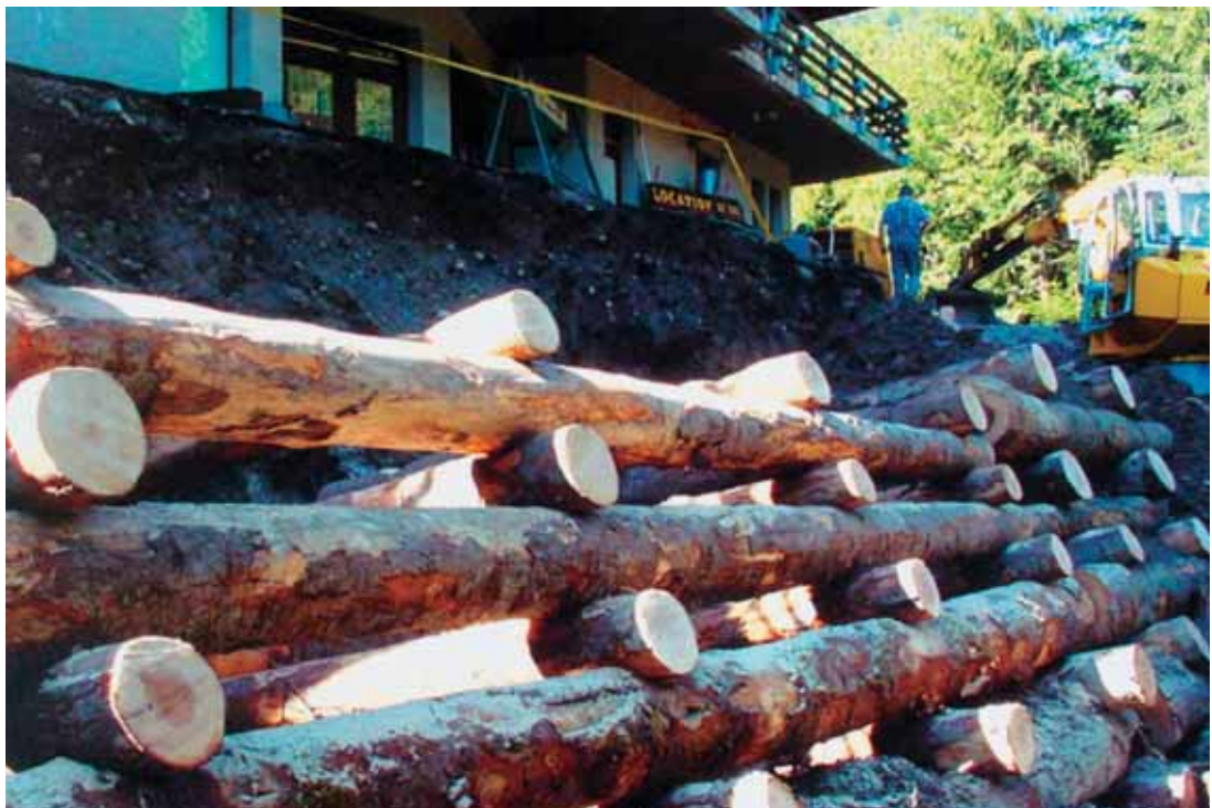
Caisson de stabilisation de terrain
