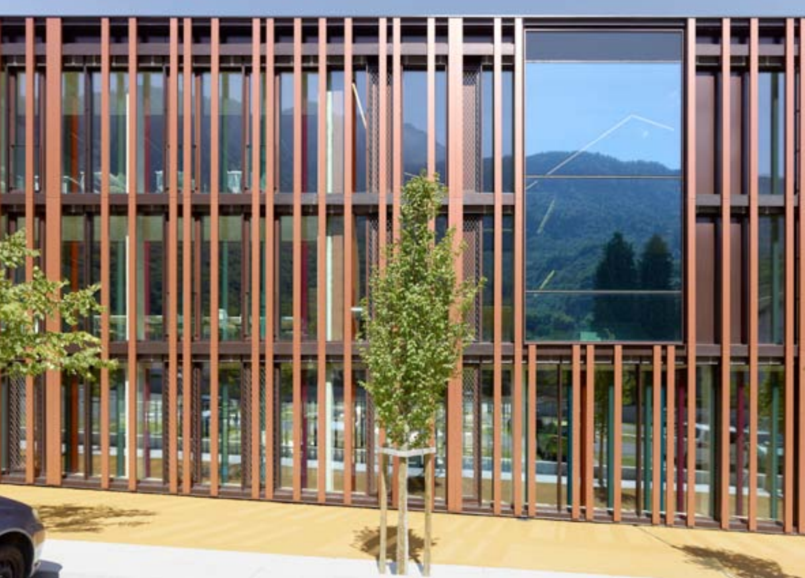
la construction de façade_côté extérieur_
