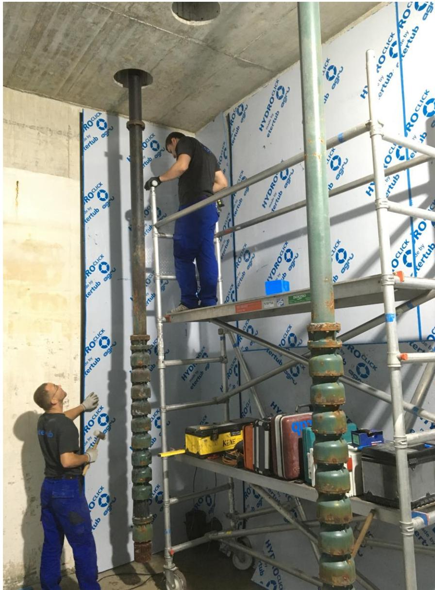
Station de refoulement de l'Avançon – mise en place d'un revêtement polyéthylène
