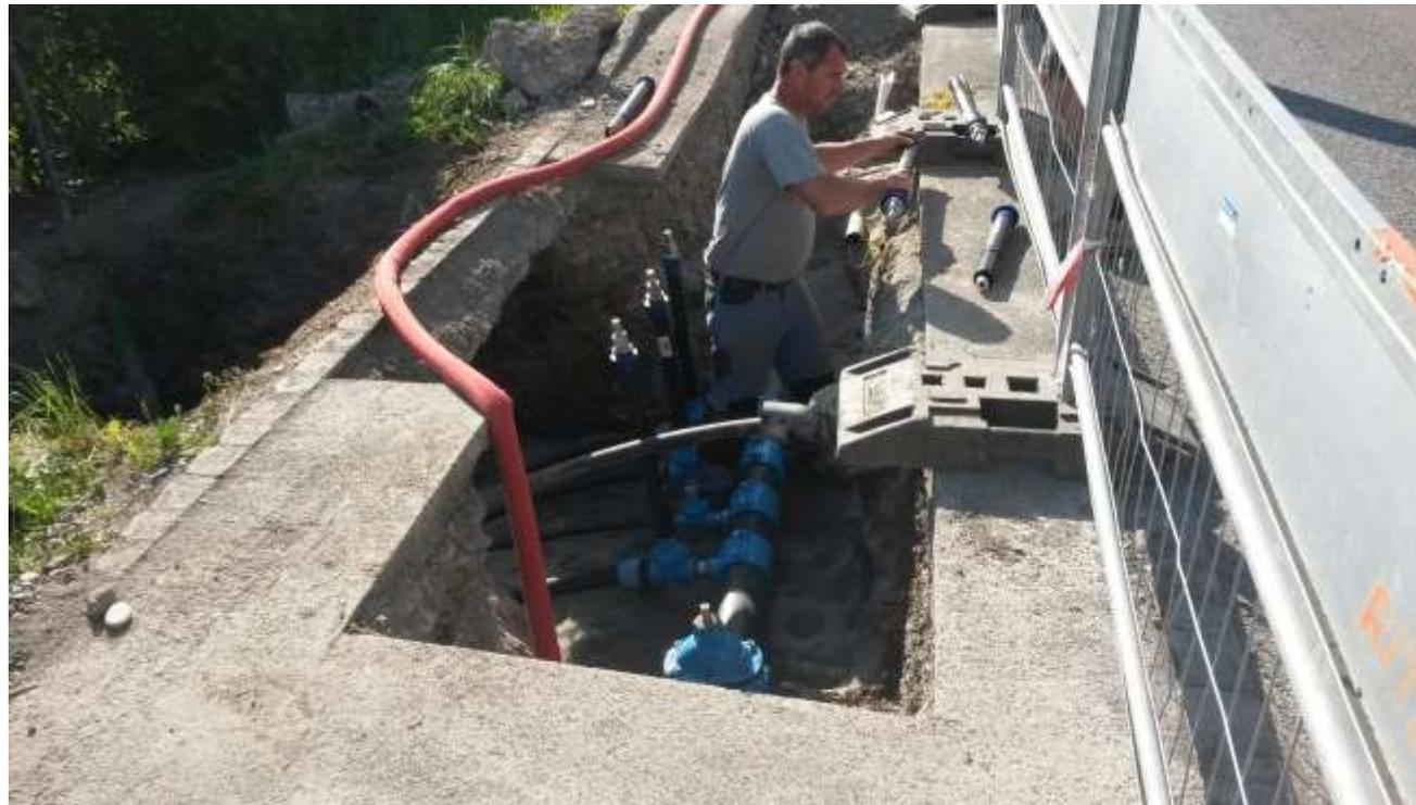
Rue du Chablais – remplacement de la conduite d'adduction et mise à neuf des prises d'eau privées
