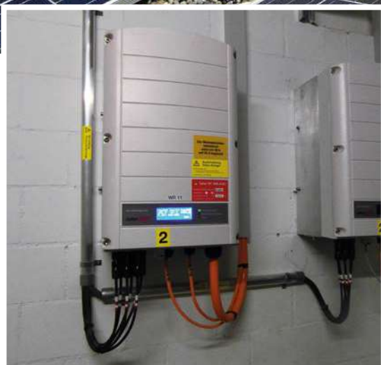
Onduleurs au sous-sol
