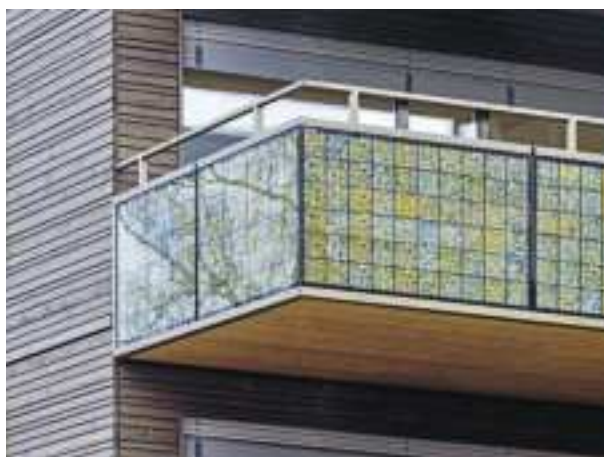
GARDE-CORPS DE BALCONS AVEC MODULES PV POLYCRISTALLINS POUR L'IMMEUBLE D'HABITATION DE LA ZWYSSIGSTRASSE, ZÜRICH Architecture : kämpfen für architektur AG, Zurich
