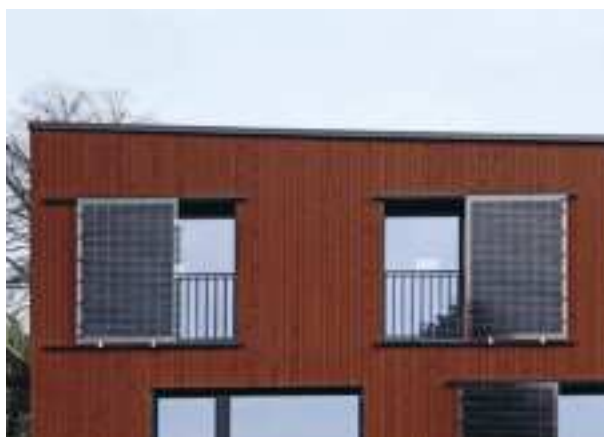
VOLETS COULISSANTS SOLAIRES POUR IMMEUBLE D'HABITATION, WIESENSTRASSE, KÜSNACHT Architecture : Vera Gloor, Zürich Partenaire spécialisé, photovoltaïque : Leutenegger Energie Control, Küsnacht
